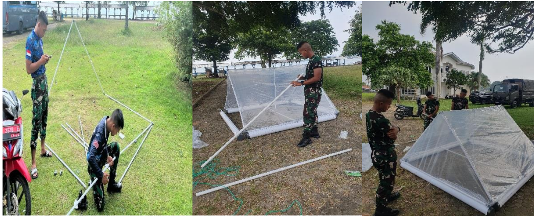
Gambar 1. Proses dan Hasil Pembuatan Prototype Solar Still
